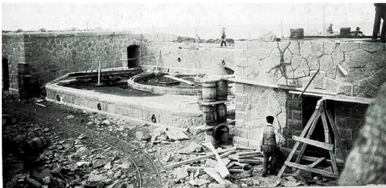
Construcción de la Batería V (Enero 1899)
