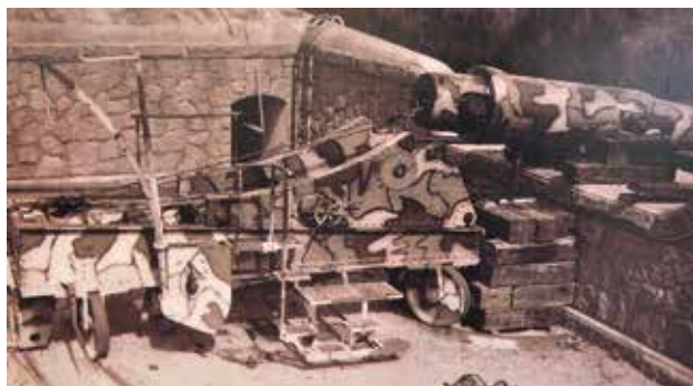
Montaje del tubo cañón (21 Tm.) en una de las baterías
